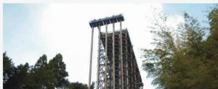
静岡県静岡市 (KOSMOS ゴンドラ工法)
