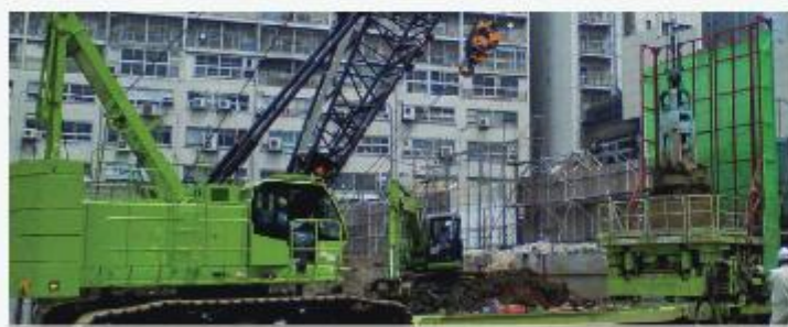
東京都渋谷区 (全周回転式オールケーシング工法)
