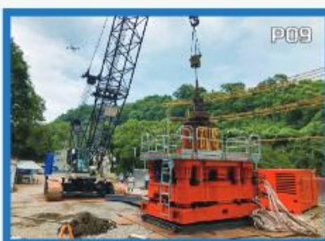
全周回転式オールケーシング工法
