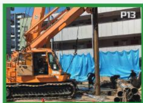
NEW-EAGLE 工法 (アースドリル工法)
