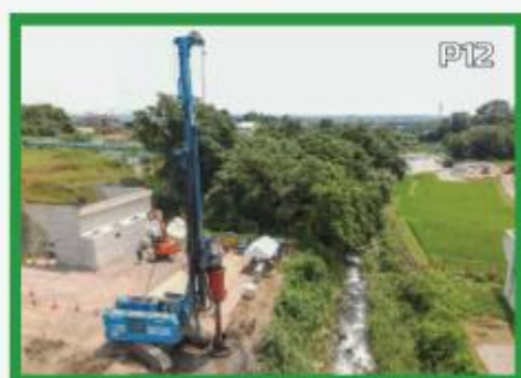
マルチドリル工法
