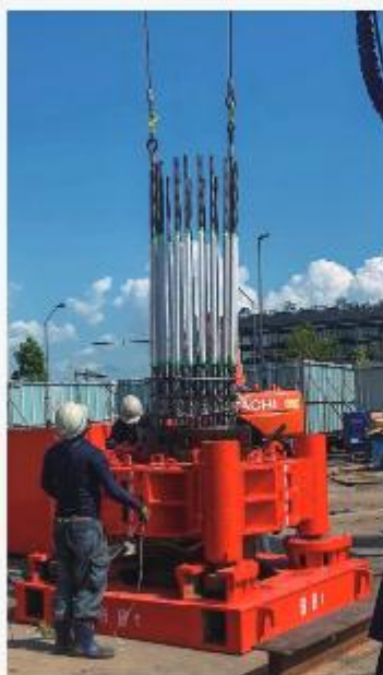
神奈川県横浜市 (マルチドリル工法)
