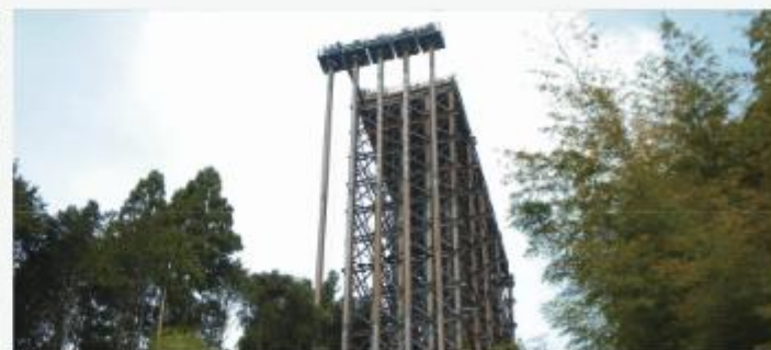
静岡県清水市（KOSMOS ゴンドラ工法）
