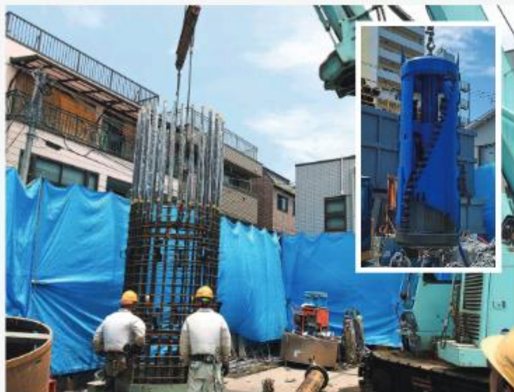
場所打ち杭施工の様子と掘削機 (右)
