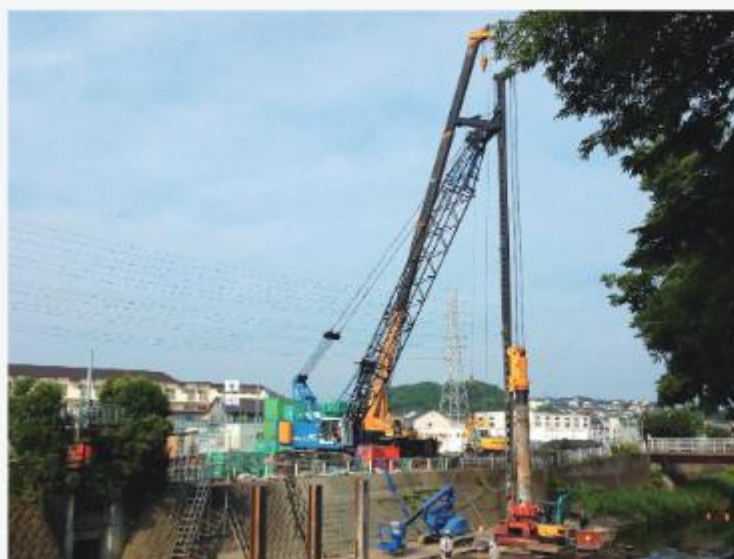
テレスコ式ロックオーガを用いた地中障害撤去の様子
