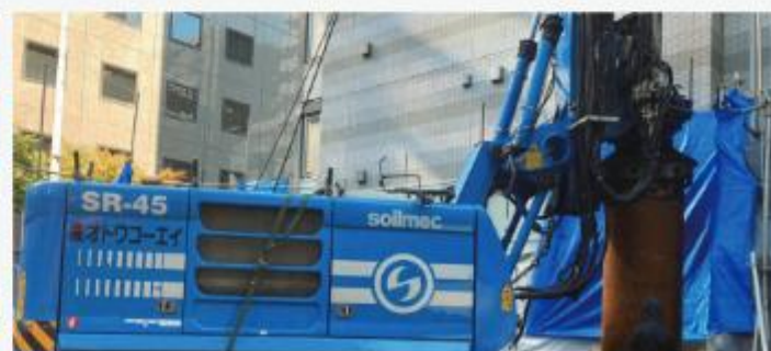
宮城県東松山市（マルチドリル工法）
