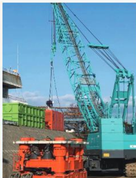
静岡県沼津市 (全周回転式オールケーシング工法)
