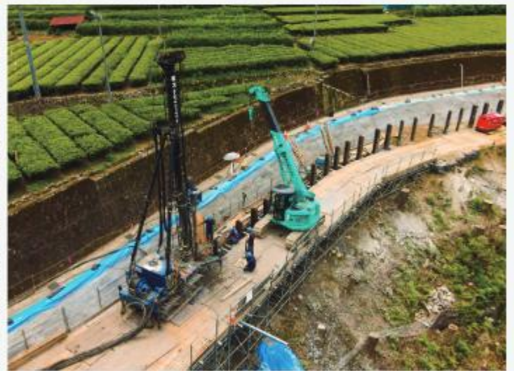
静岡県静岡市 (OTO ドリル工法)
