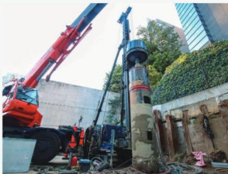
OTO 掘削機 ミニロック工法仕様
