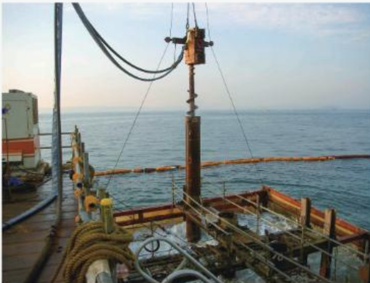
リングビット工法併用吊り下げ式工法を用いた海上施工の様子
