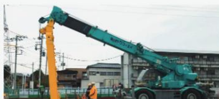
山梨県甲府市（多滑車引抜工法）
