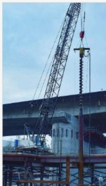
埼玉県深谷市 (吊り下げ式工法)
