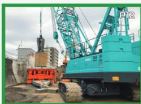
全周回転式オールケーシング工法
