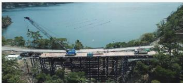
宮城県東牡鹿郡（ロードリル工法 他）
