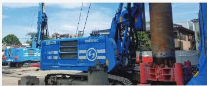
神奈川県横浜市 (マルチドリル工法)
