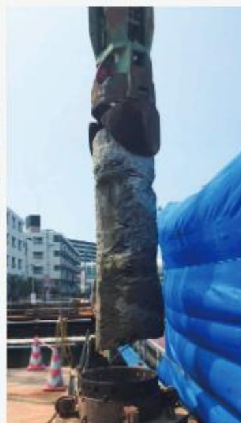
千葉県船橋市 (マルチドリル工法)
