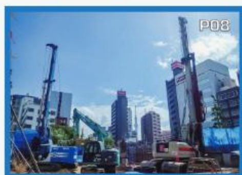
マルチドリル工法
