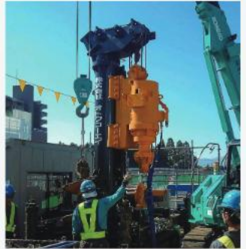
東京都町田市 (OTO ドリル工法)
