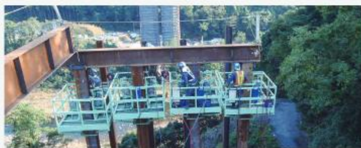
神奈川県相模原市 (KOSMOS ゴンドラ工法)
