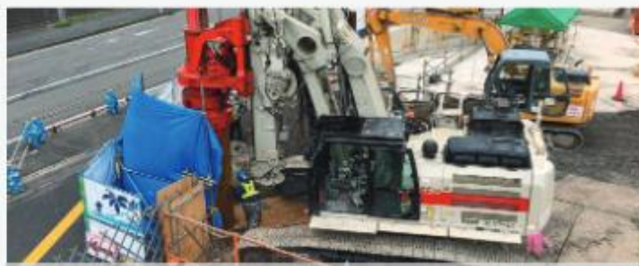
神奈川県横浜市 (マルチドリル工法)
