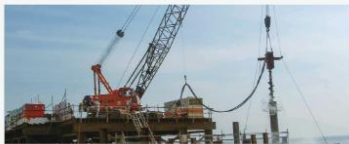
千葉県高津市 (吊り下げ式工法)
