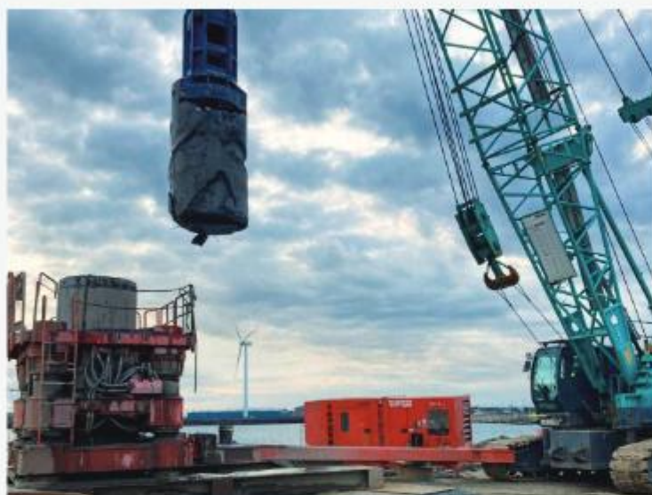
ハンマーグラブを用いた地中障害撤去の様子
