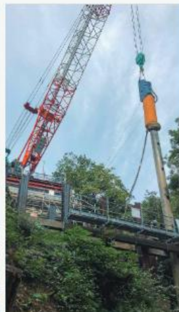
東京都西多摩郡 (吊り下げ式工法)
