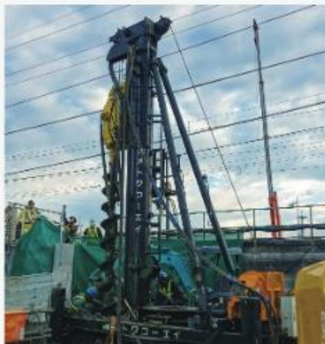
山梨県甲府市 (OTO ドリル工法)
