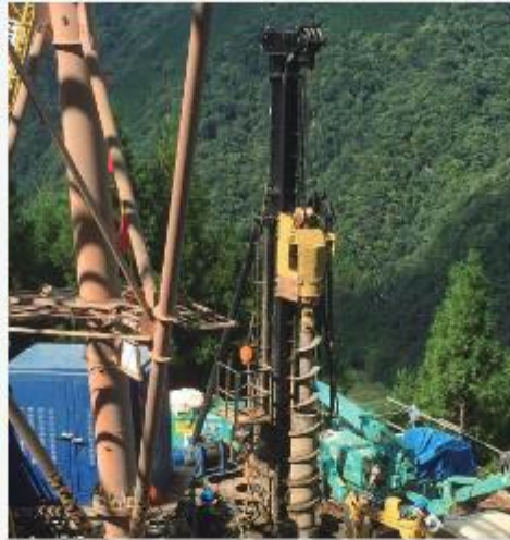
神奈川県養野市 (OTO ドリル工法)
