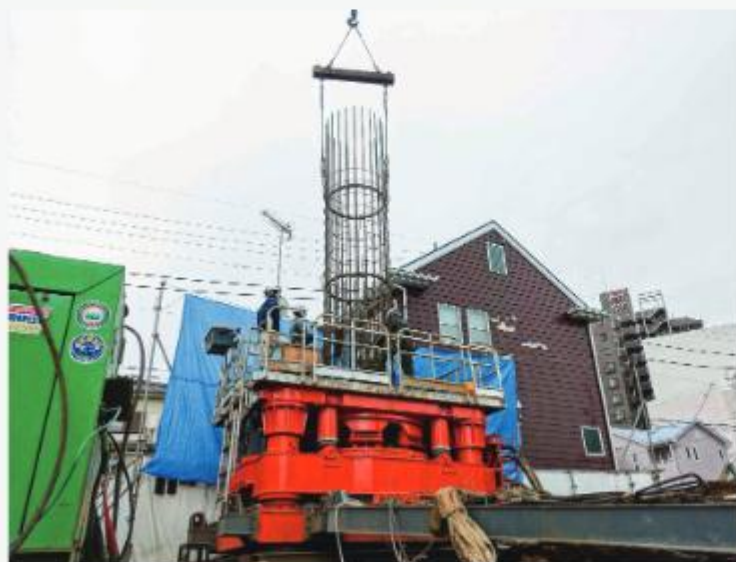
鉄筋カゴ建て込みの様子
