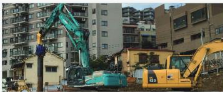
静岡県熱海市 (ロックオーガ工法)
