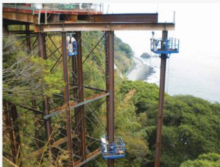
60.0m 級橋台における KOSMOS ゴンドラ施工の様子
