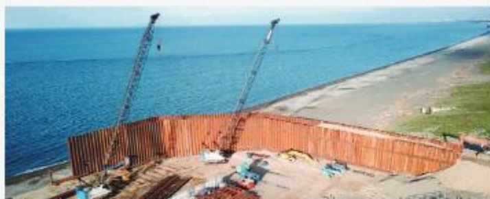
静岡県沼津市 (パイプロハンマ工法・他多数工種)
