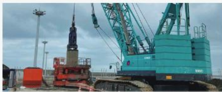
茨城県鹿嶋市 (全周回転式オールケーシング工法)
