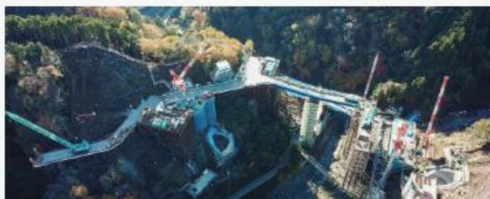
神奈川県足柄上郡 (仮橋工事・他多数工種)
