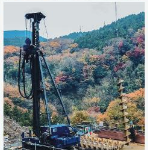
神奈川県足柄上郡 (OTO ドリル工法)
