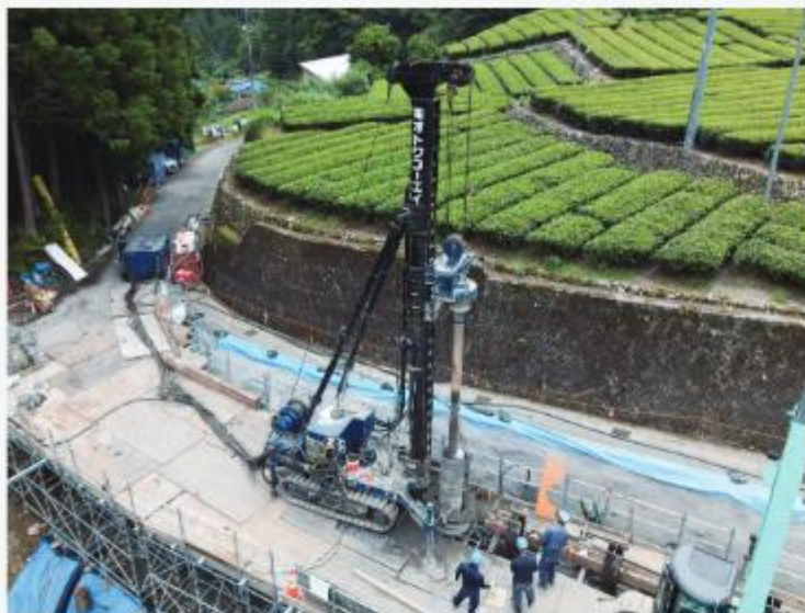
OTO 掘削機を用いた抑止杭打設施工風景
