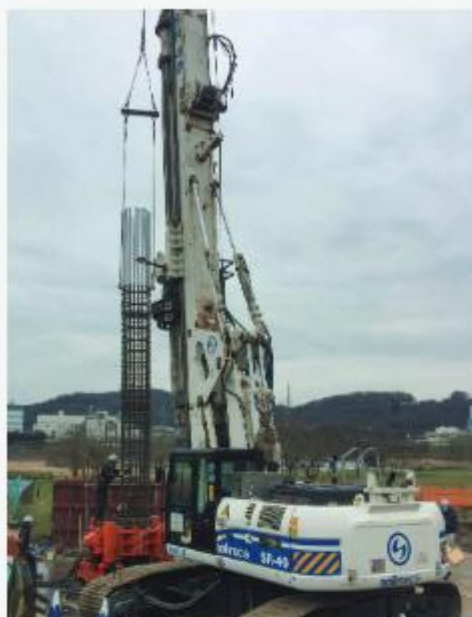
東京都府中市 (マルチドリル工法)
