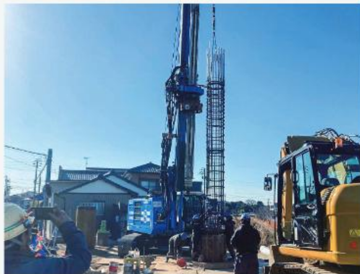
マルチドリル掘削機を用いた鉄筋カゴ建て込みの様子
