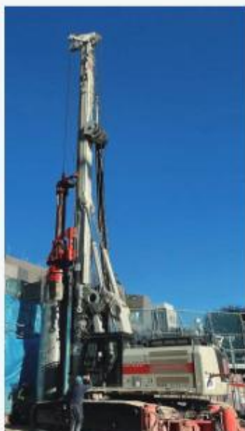
東京都渋谷区 (マルチドリル工法)
