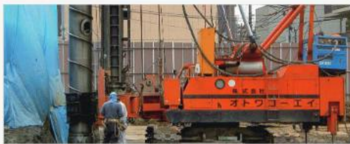
東京都目黒区 (ロックオーガ工法)
