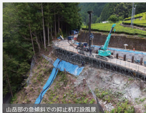
山岳部の急傾斜での抑止杭打設風景
