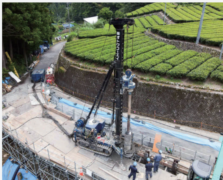
OTO® 掘削機を用いた抑止杭打設施工風景
