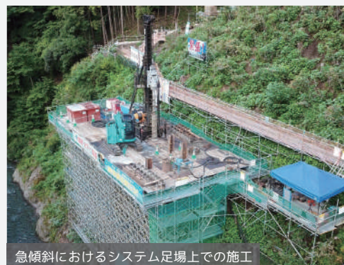
急傾斜におけるシステム足場上での施工
