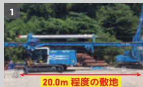
マルチドリル掘削機 (SR-45) 組立時体制図
