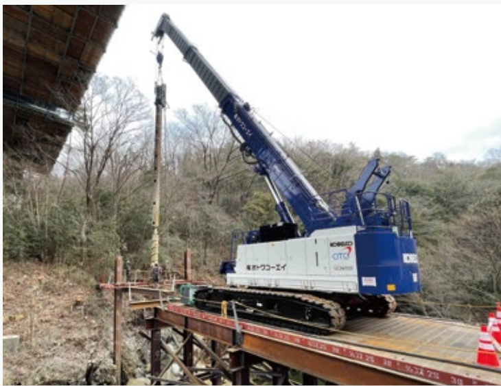
吊り下げ式工法を用いた急傾斜地施工の様子
