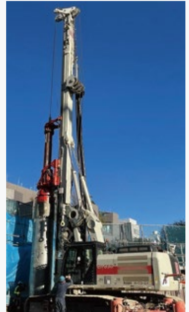
東京都渋谷区 （マルチドリル工法）
