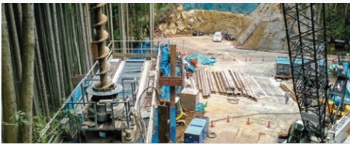
愛知県豊田市（ロードドリル工法）
