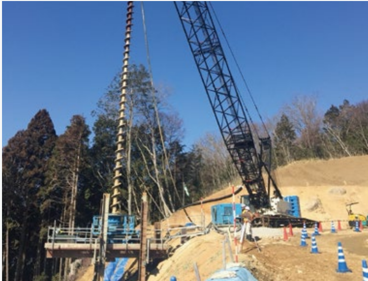
ロアードリル工法を用いた急傾斜地施工の様子
