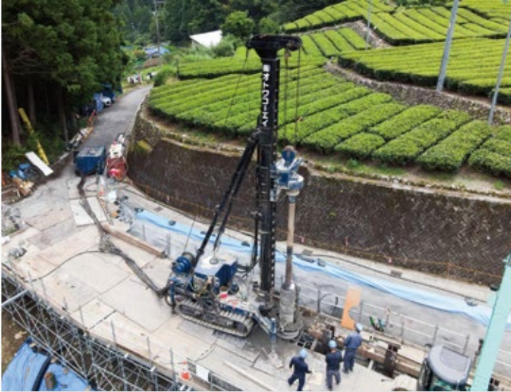
OTO® ドリルを用いた抑止杭打設施工風景
