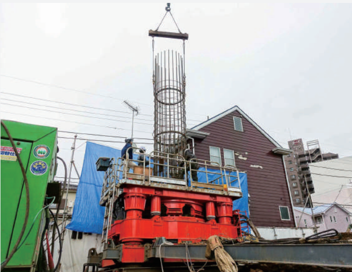
鉄筋カゴ建て込みの様子
