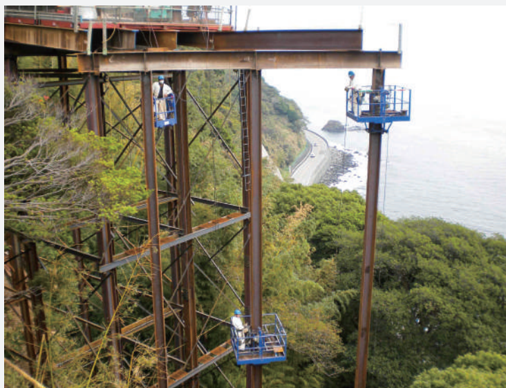
60.0m 級構台におけるゴンドラ施工の様子
