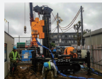
OTO® 掘削機短尺リーダー仕様
