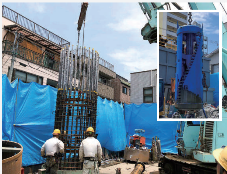
場所打ち杭施工の様子と掘削機 (右)
