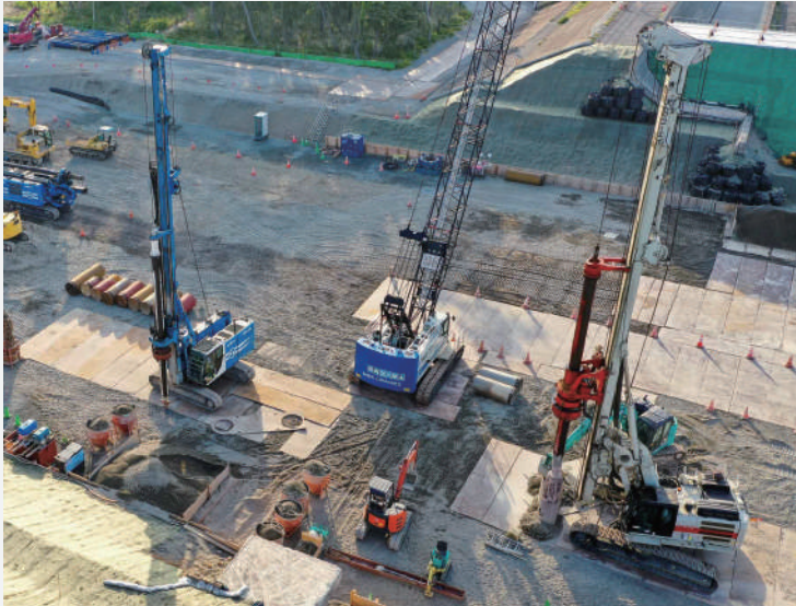
マルチドリル掘削機 SR-45（左）と CH 650（右）
