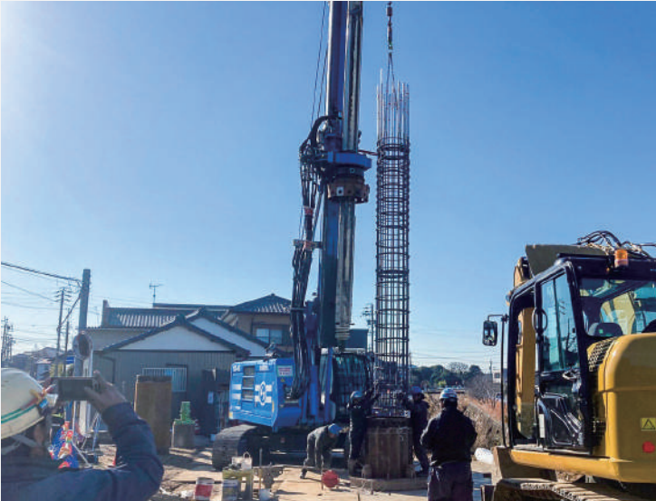
マルチドリル掘削機を用いた鉄筋カゴ建て込みの様子
