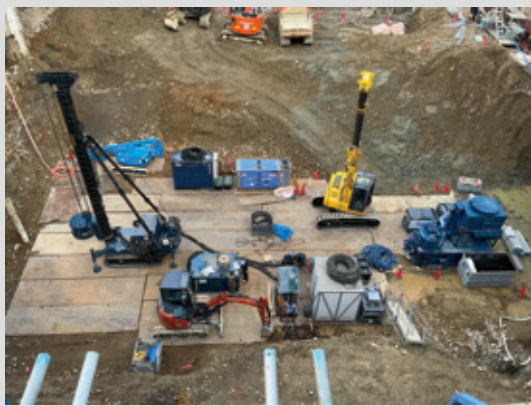
狭隘地における資機材配置イメージ写真
