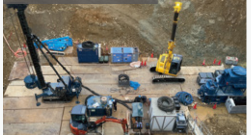
OTO® 掘削機 施工地組立後の様子
