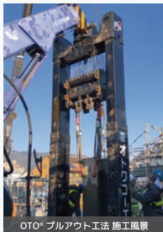
OTO® ミニロック工法 施工風景
